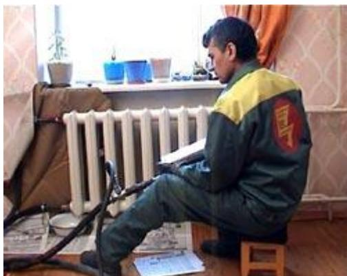
Компактный и удивительно простой в применении прибор позволяет выполнить точечную очистку радиаторов отопления, прочистить засор в водопроводе и канализации диаметром до 150мм. При этом расстояние от точки выстрела пневмопистолета ТАЙФУН® до засора может составлять до 50 метров.
